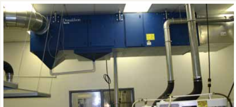
MODULAR MEDIA Pulverización 2,000 cfm
